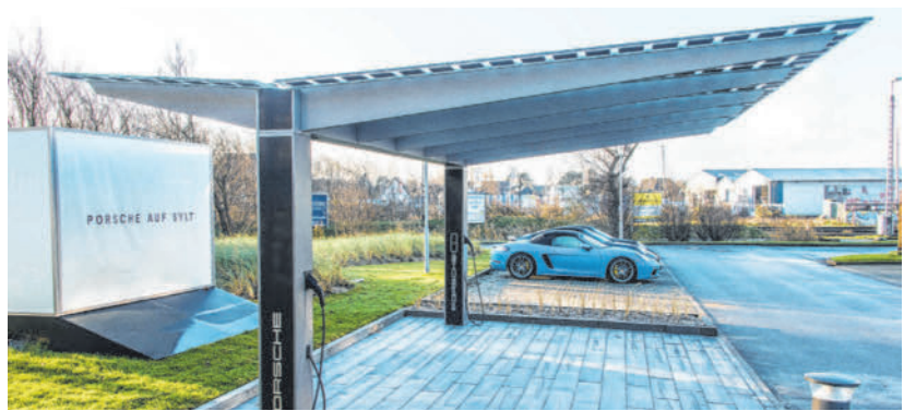
Gemeinsam mit einem Stuttgarter Designbüro realisierte I+R Energie in 15 Monaten Entwicklungszeit einen Photovoltaik-Carport.
