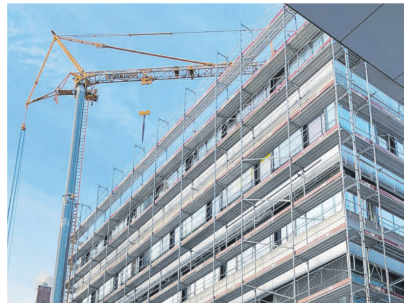
Am Campus der FH Vorarlberg wird mehr Platz für die Studierenden geschaffen. Der Ausbau schreitet zügig voran.
